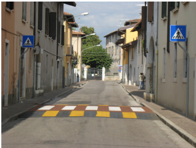
Foto 1 Attraversamento pedonale rialzato
