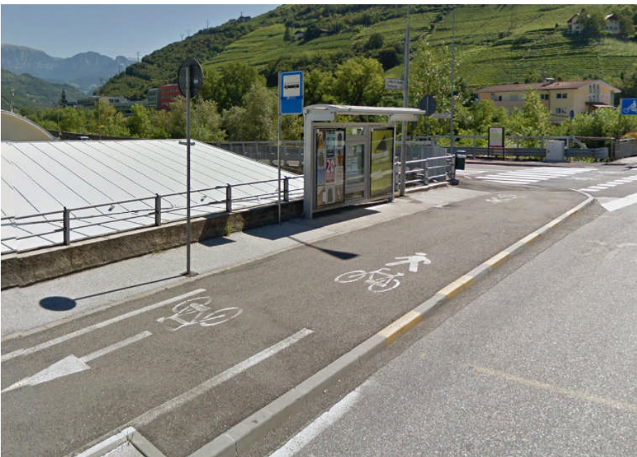
Foto n.2 – Bolzano – Fermata bus con percorso ciclabile
